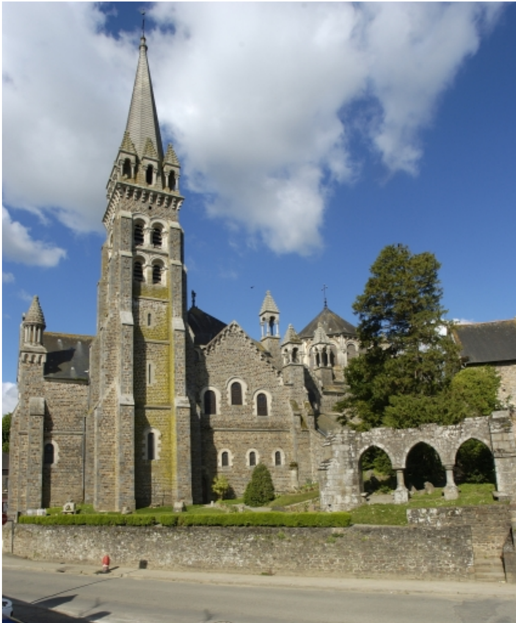
Elévation nord-est et vestiges de l'ancienne église
