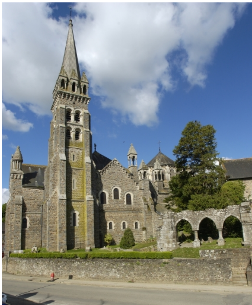
Elévation nord-est et vestiges de l'ancienne église
