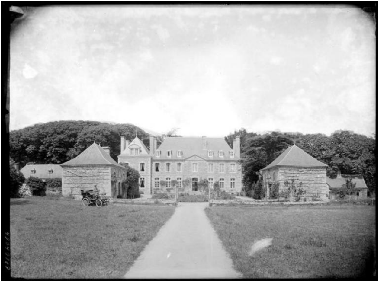
Ploubezre : château de Coatilliau, vue générale sud, vers 1900-1920 (collection particulière)
